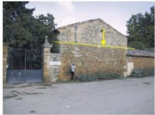
Vers Pont du Gard : "La Bégude St Pierre",
