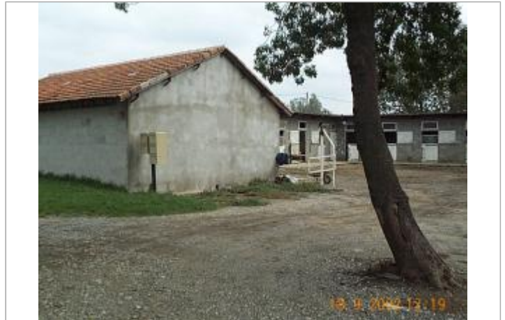
Vue du site
