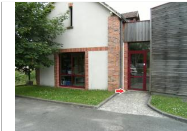
Site et emplacement du repère de la crue de juin 2016
