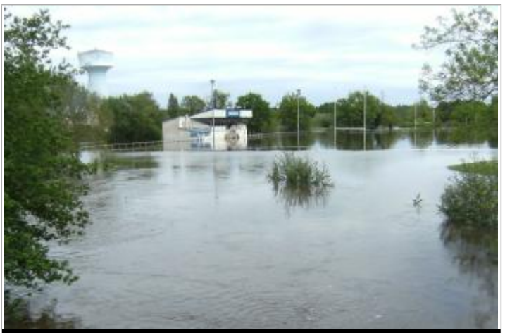
Site pendant la crue de mai 2015
