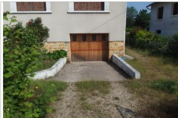
Site et repère de la crue de 2016
