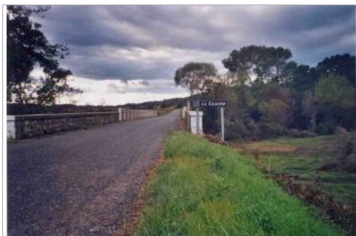
Vue du site
