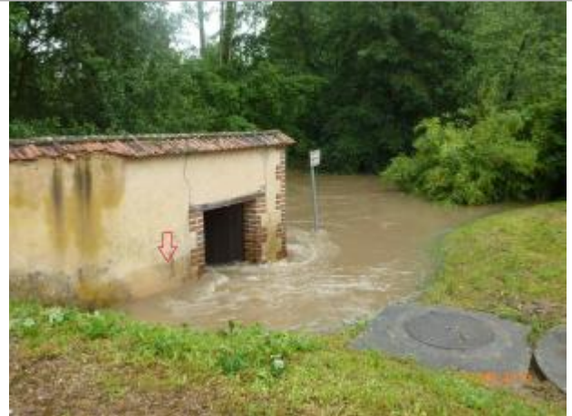
Lavoir rue de Fervaches (photo DDT 28)
