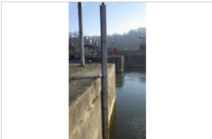
Echelle aval de l'écluse de Creil à St Leu d'Esserent
