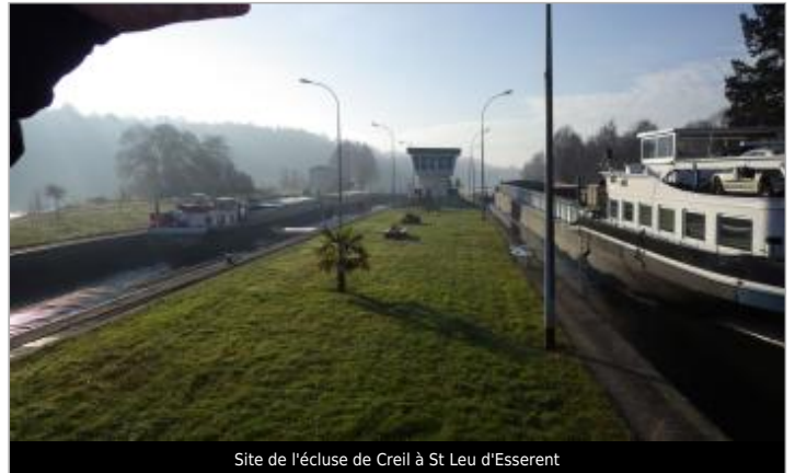
Site de l'écluse de Creil à St Leu d'Esserent
