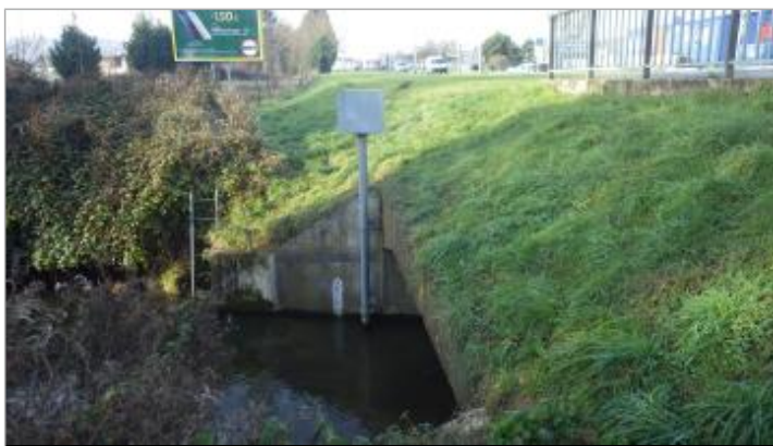
Echelle de la station Soissons Crise
