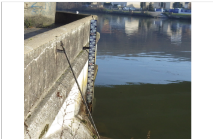
Echelle de crues, repère du 6 février 1995 à 29,31 m NGF normal
