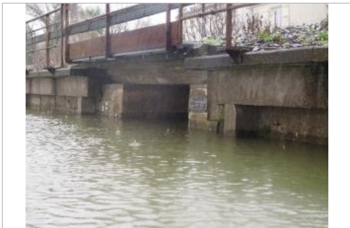
Niveau eau au pic
