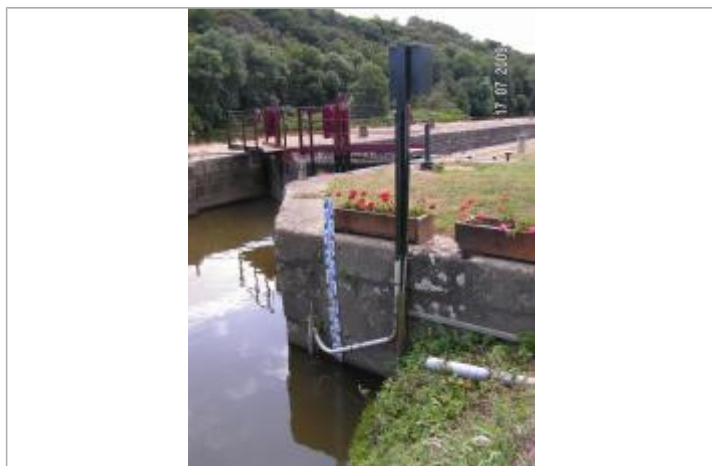
Echelle limnimétrique sur bajoyer amont de l'écluse du Boel
