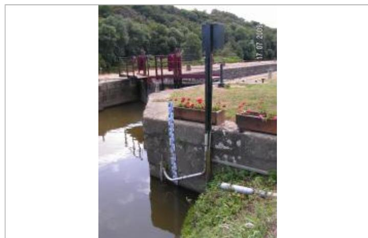
Echelle limnimétrique sur bajoyer amont de l'écluse du Boel
