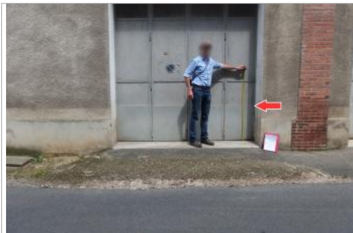
Site et repère de la crue de juin 2016
