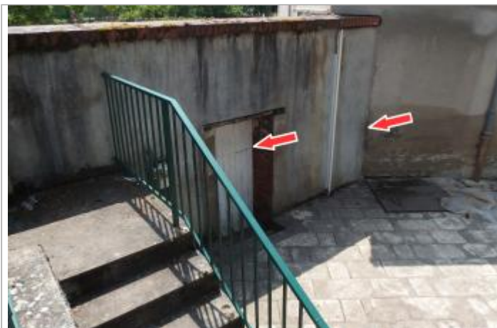
Vue du site et du repère de la crue de 2016
