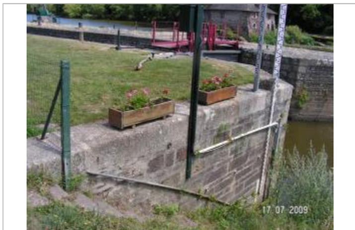
Echelle limnimétrique sur bajoyer aval de l'écluse du Boel
