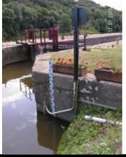
Echelle limnimétrique sur bajoyer amont de l'écluse du Boel
