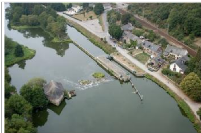
vue générale du site du Boel à Guichen
