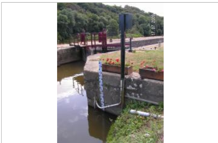
Echelle limnimétrique sur batardeau amont de l'écluse du Boel
