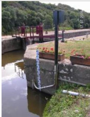
Echelle limnimétrique sur bajoyer amont de l'écluse du Boel
