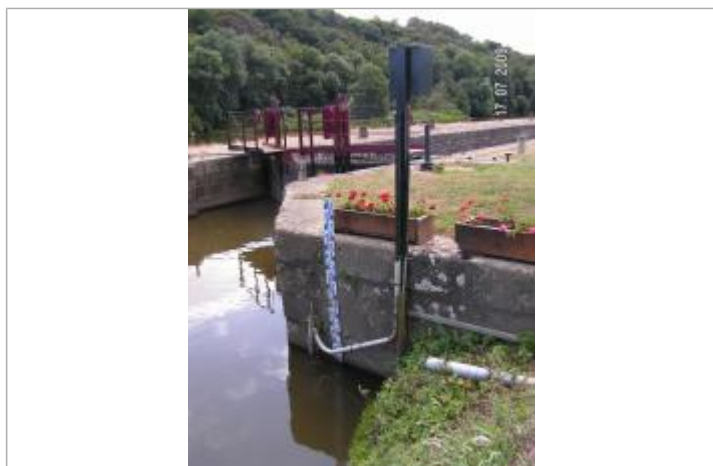
Echelle limnimétrique sur bajeoyr amont de l'écluse du Boel
