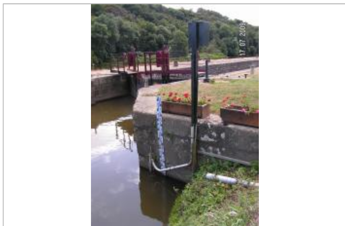
Echelle limnimétrique sur bajeoy amont de l'écluse du Boel
