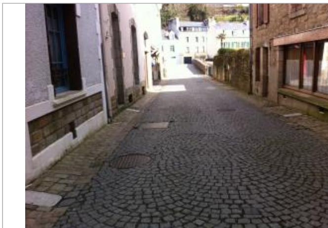
rue de l'Ellé, bâtiment au n°10
