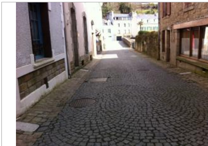
rue de l'Ellé, bâtiment au n°10
