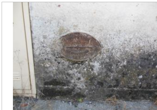
Plaque métallique située sur la façade Nord-Ouest du bâtiment situé derrière la pépinière d'entreprise à 45 cm au-dessus du sol
