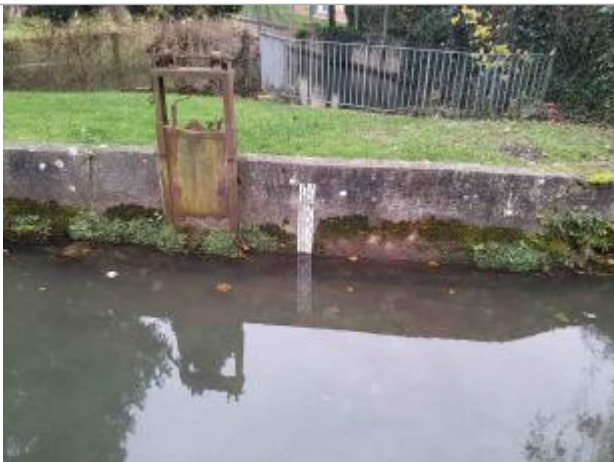
Echelle de crues sur rivière St Just
