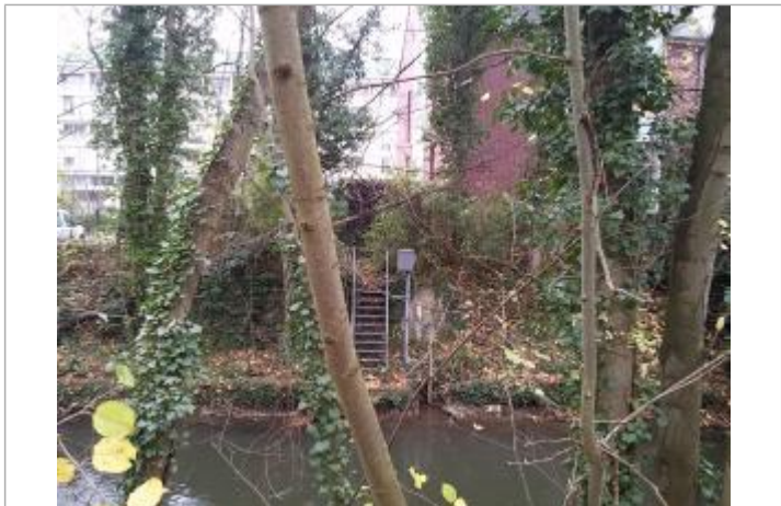
Echelle de la station de Beauvais
