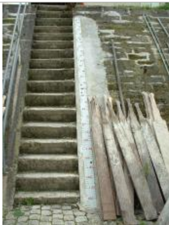
échelle de crue
