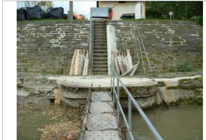
Station de Biermes au barrage
