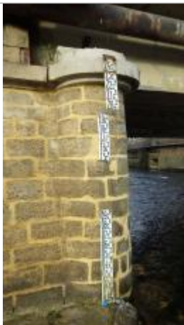
Echelle de crue en aval du pont sur la Serre, rive gauche
