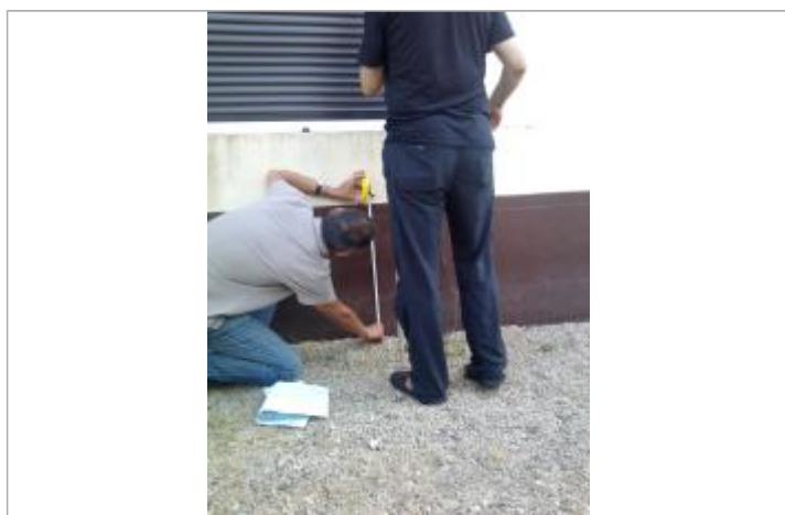
Maison située au 613 chemin de Halage
