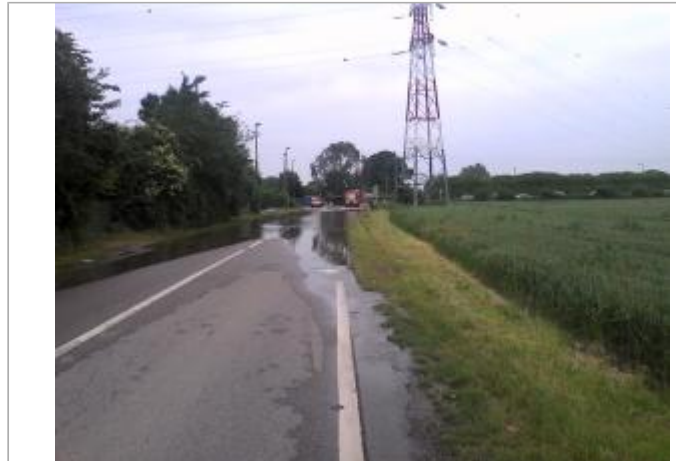
Route de Cléon et Saint-Aubin-lès-Elbeuf
