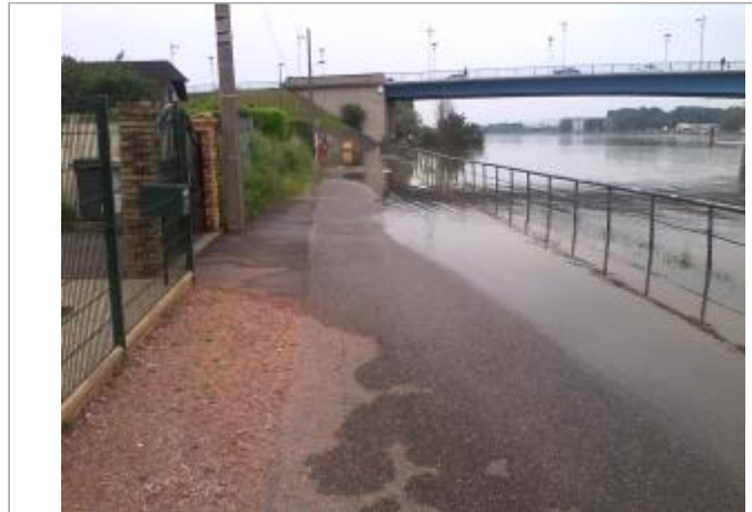
Entrée du 760 chemin de halage à SAINT-AUBIN-LES-ELBEUF
