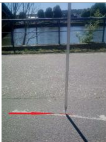
Sol de la chaussée, Chemin du Halage (proximité du pont Jean Jaures)
