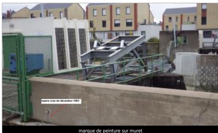
marque de peinture sur muret
