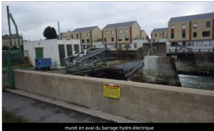
muret en aval du barrage hydro-électrique
