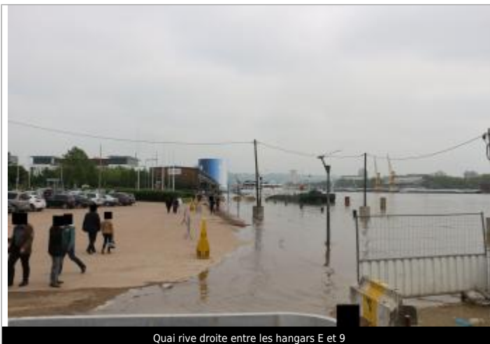
Quai rive droite entre les hangars E et 9
