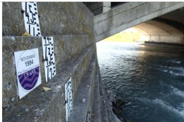
Repère plus hautes eaux connues du Var au pont Napoléon III (crue du Var du 5 novembre 1994)
