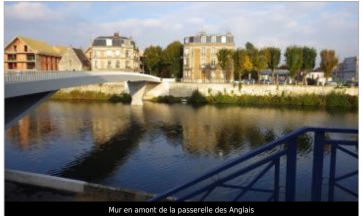
Mur en amont de la passerelle des Anglais
