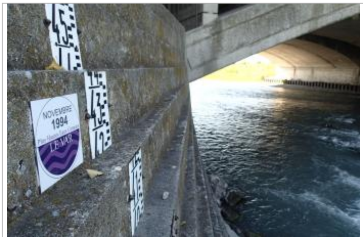
Repère plus hautes eaux connues du Var au pont Napoléon III (crue du Var du 5 novembre 1994)
