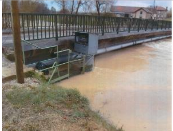
Station de Chevières, rive droite, aval du pont
