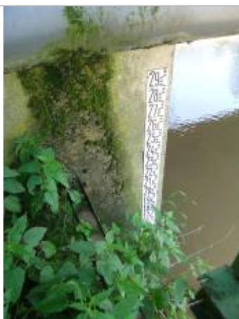
échelle de crues sur pile aval du pont
