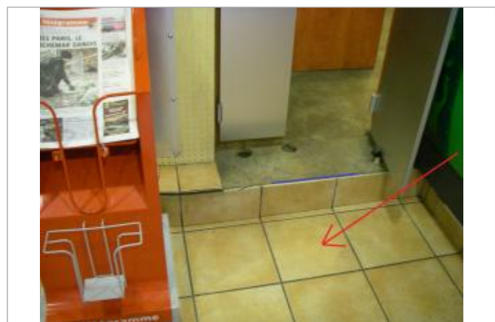
Plancher du rez-de-chaussée au droit de la marche du bar.
