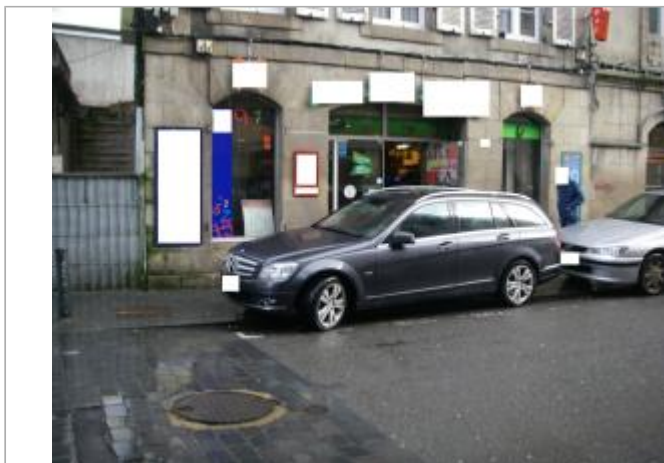
Magasin 20 rue de Brest - Photographie DHE 2015
