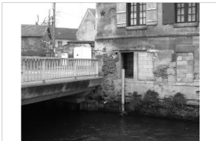
échelle de crues sur bâtiment amont du pont sur le Thérain en rive droite
