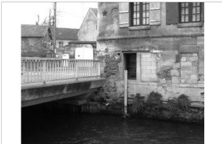
échelle de crues sur bâtiment amont du pont sur le Thérain en rive droite
