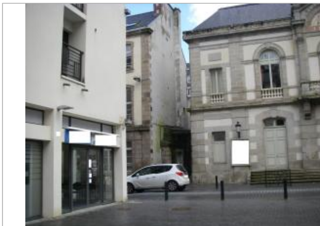
Magasin 28 rue de Brest - Photographie DHE 2015
