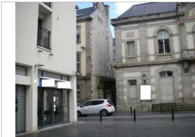
Magasin 28 rue de Brest - Photographie DHE 2015
