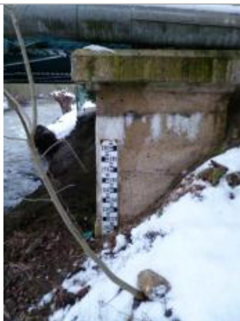
échelle de Braine sur la culée du pont
