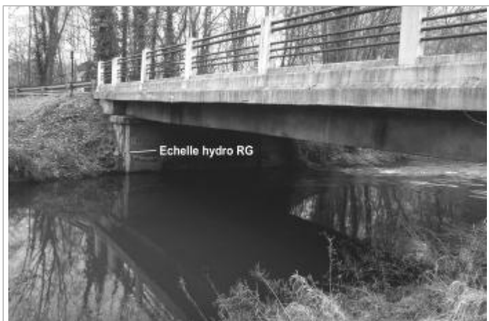
échelle de crues sur la pile du pont en rive gauche
