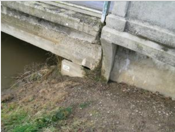
Plaque 13 décembre 1966 pile aval du pont en rive gauche
