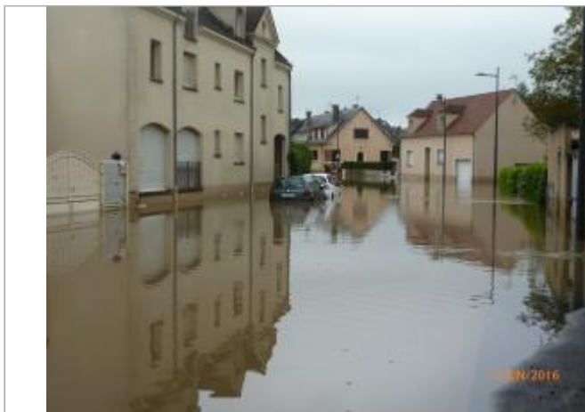
Vue d'ensemble de la rue Peju (photo DDT 28)
