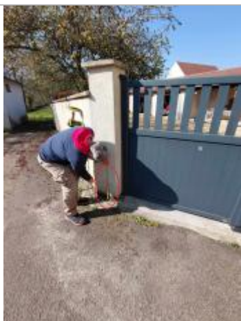
Laisse de crue à environ 27 cm/sol.
