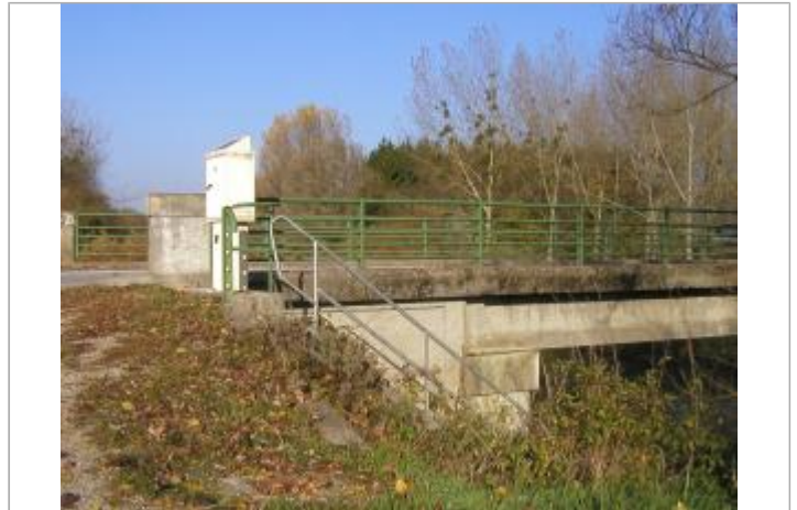
station de Givry en amont du pont de la RD 43
