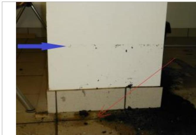
niveau d'eau atteint au dessus du plancher du rez-de-chaussée du bâtiment - Photographie DHE 2015
