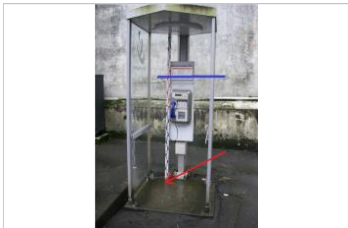
Cabine téléphonique, parking du supermarché situé rue de Brest - Photographie DHE 2015
