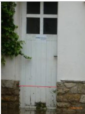
Laisse d'inondation sur la porte arrière (photo DDT 28)
