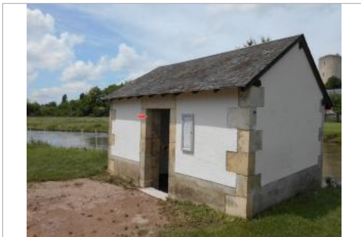
Site et repère de la crue de 1910
