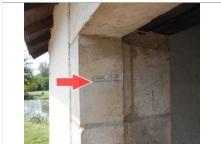
Détail du repère
